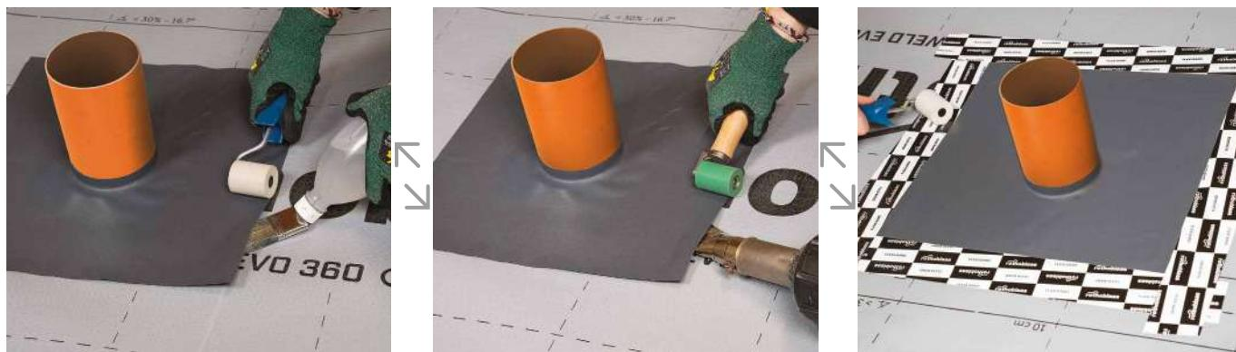
ROLLER, WELD LIQUID, CUTTER, HOT GUN
